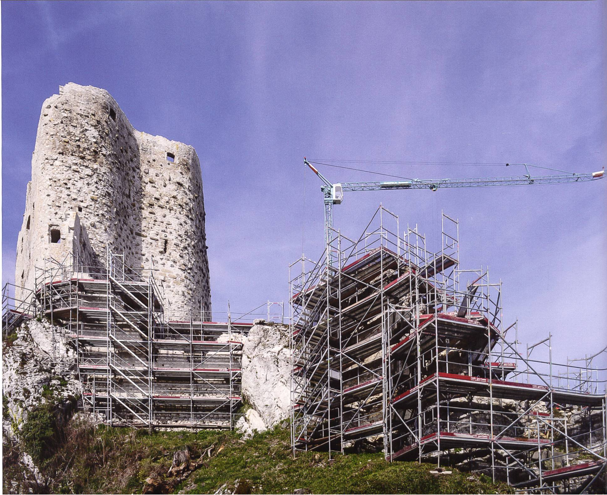
Ruine Pfeffingen. Die eingerüsteten östlichen Bauten im Sommer 2015.
