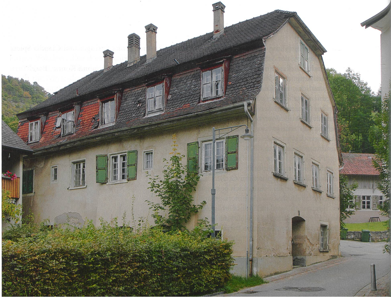
Eptingen, Läuferfingerstrasse 5. Gestalt des Badhauses seit dem Umbau und der Erweiterung des 19. Jahrhunderts.
