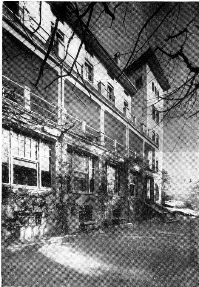
Liegehallen in einem Gebäude der Militärheilanstalt Novaggio.
