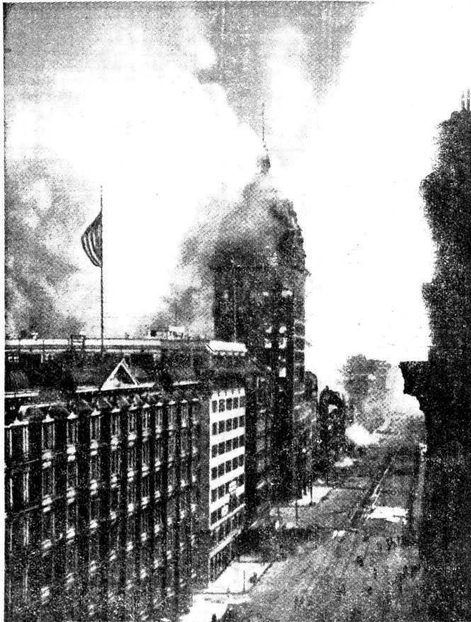
Grossfeuer nach dem Erdbeben in San Francisco. Die Bauten haben das Beben überstanden, sind aber nachher durch Grossfeuer zerstört worden.
