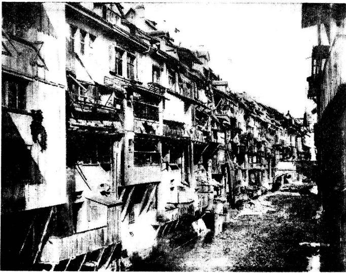
Alte Häuser am Birsig in Basel. Aufgenommen 1886, vor der Birsigkorrektur. Das im Vordergrund links sichtbare, vorgebaute Holzhäuschen ist einer der typischen Abtritte, von dem der Unrat direkt in das Flüsschen gelangte.
