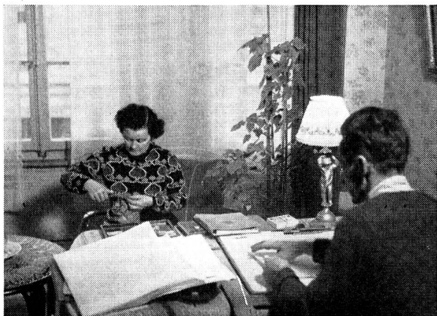
Hans Meyer vom Filmdienst des Eidg. Militärdepartements kontrollierte in seinem gut eingerichteten Atelier einen Film, als wir ihn im Parlamentsgebäude, hoch oben unter dem Dach, überfielen. Auch er erkundigte sich eingehend nach der Familie Wyss. Er selber habe auch zwei Kinder von sieben und zwölf Jahren.
