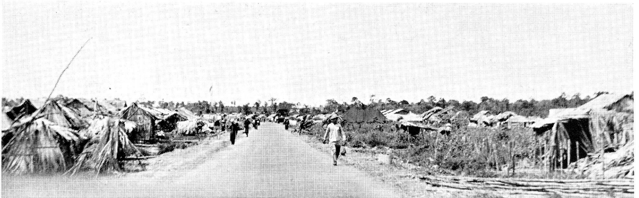
Eine Strasse in der Gegend von Bien Hoa, wo links und rechts der Wald abgeholzt wurde und nun eine binsengedeckte Hütte nach der andern entsteht. Rund 100 000 Flüchtlinge sollen hier angesiedelt werden und Land zum Bebauen erhalten.
