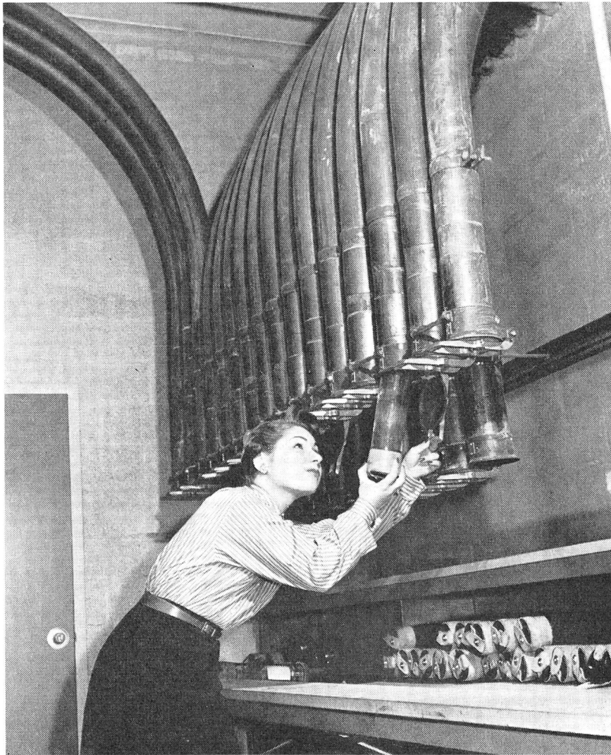
Wird eine Arznei aus der Apotheke verlangt, so kann diese dank der Rohrpost unverzüglich geliefert werden, ohne dass die Schwester oder das Hilfspersonal zeitraubende Gänge auf sich nehmen müssen. Dieses Bild zeigt den Spitalapotheker, der eine eingetroffene Arzneibestellung sofort ausführt.
