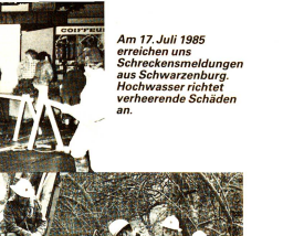
Am 17. Juli 1985 erreichen uns Schreckensmeldungen aus Schwarzenburg. Hochwasser richtet verheerende Schäden an.
