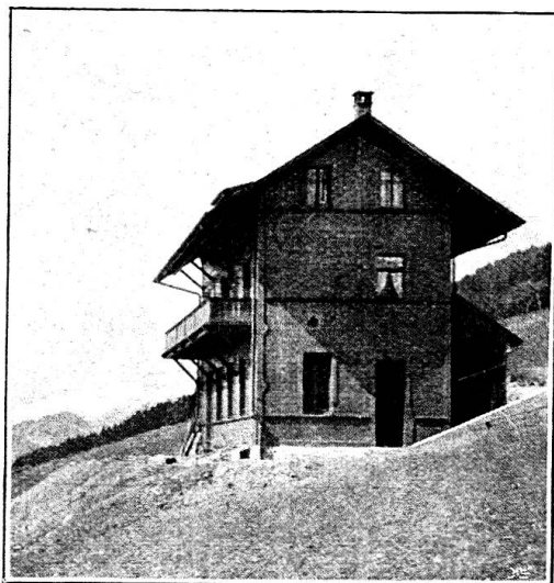
Bâtiment de la Colonie de travail à Leysin
