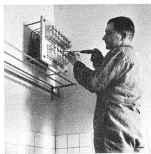
Ne vous amusez pas à «bricoler» dans l'installation électrique, faites appel à un électricien qualifié. Ne remplacez pas provisoirement le fusible qui a sauté par du papier d'étain ou un fil métallique, attendez de mettre un fusible neuf.
