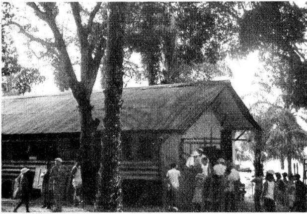
A Lambaréné, une des nombreuses cases du village-hôpital. (Photo D r Chausse.)
