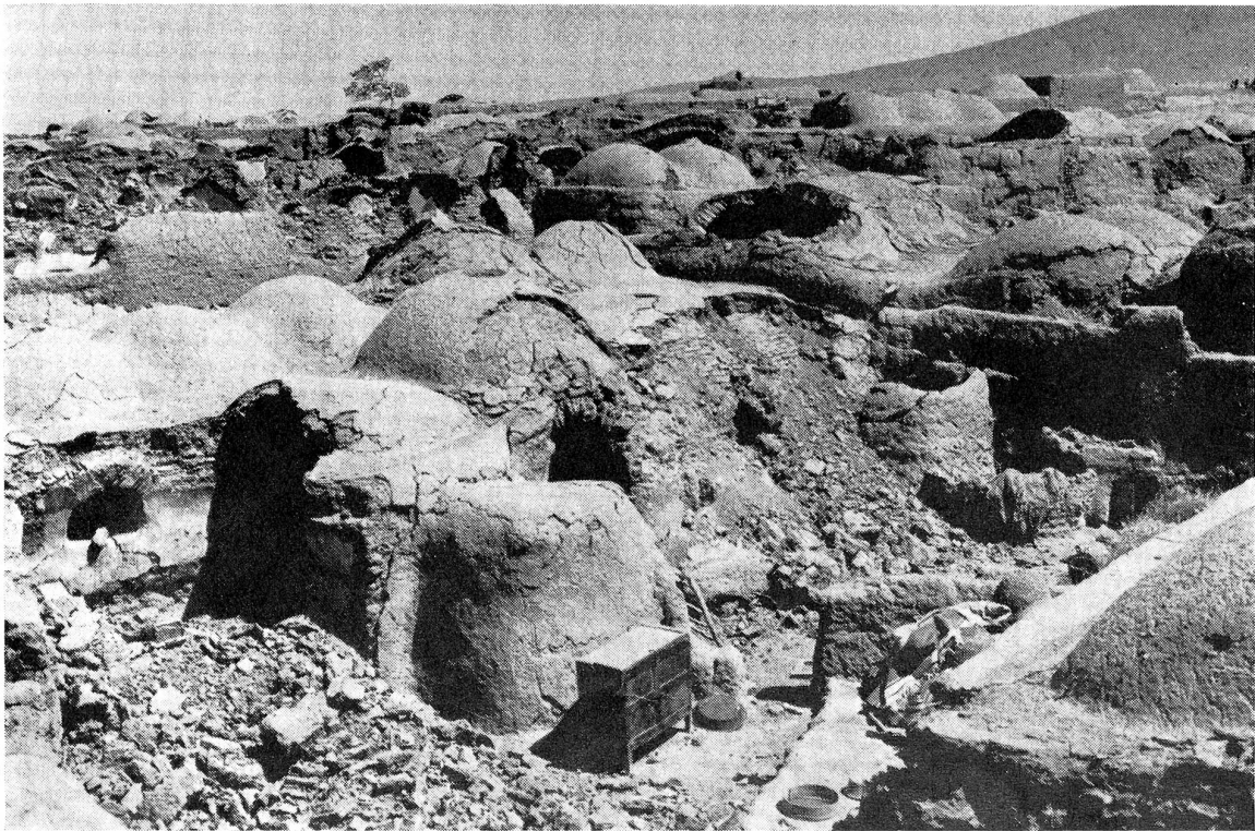
Ce qu'il reste d'un village iranien au lendemain des séismes qui ont ravagé à nouveau ce pays. Aucune de ces huttes de briques et de pierres n'est habitable (Photo de la Ligue des sociétés de la Croix-Rouge)
