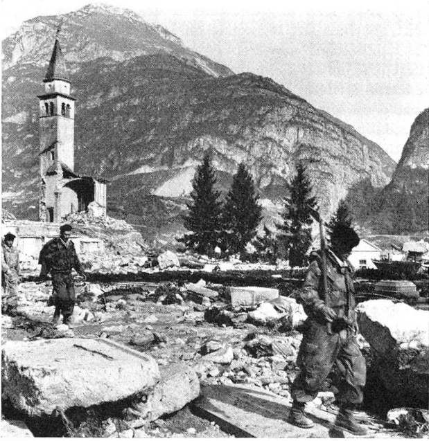
Octobre 1963: une vallée entière est anéantie; bilan du désastre: 2500 morts, des blessés, de très rares survivants. A Longarone, seuls quelques maisons et le clocher de l'Eglise ont échappé à la destruction
