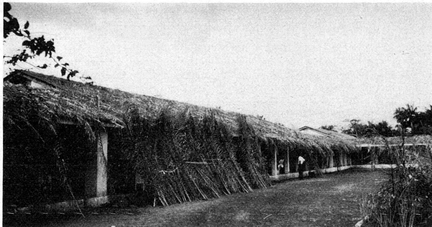
Vista parziale dell'ospedale di Aboh.
