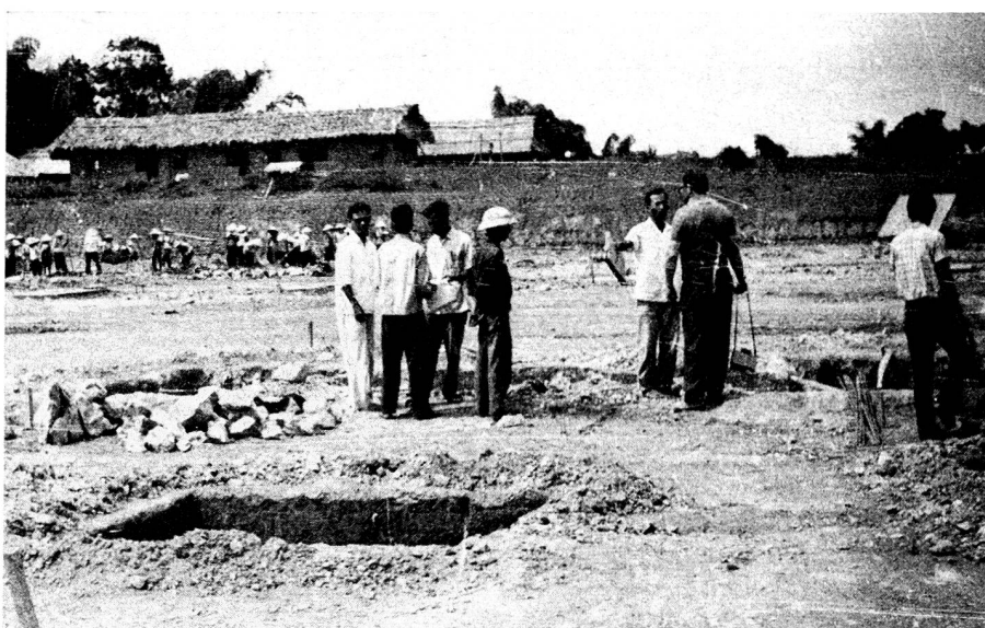
La fabrique de Viet Tri est déjà en chantier. Alors que ses éléments seront fournis par la Suisse, le terrain, les fondations et les voies d'accès sont préparés et mis en place par les Vietnamiens qui exécuteront également les travaux de construction et de montage, selon les instructions des spécialistes suisses. La fabrique commencera de produire au début de 1976.
