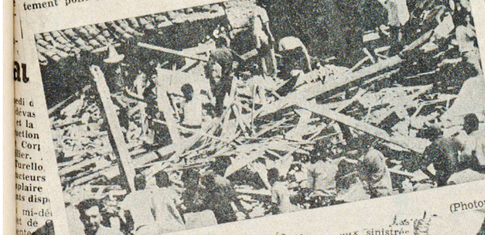
Managua, une ville complètement rasée... (Photopress)
