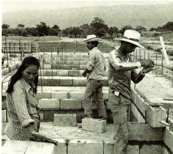
A Armero-Guayabal, la reconstruction se fait selon le principe de l'«autoconstruction»; les bénéficiaires du programme participent activement aux travaux. (Photo: Kurt Bolliger)
