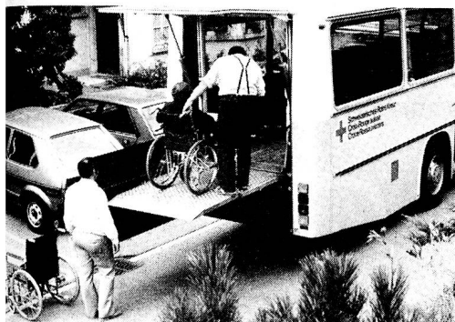
Un des trois autocars pour handicapés de la Croix-Rouge suisse: une plate-forme élévatrice facilite le chargement et le déchargement des chaises roulantes.
