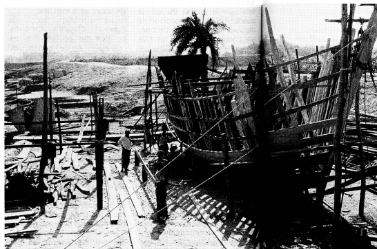
Pour exercer une activité artisanale, par exemple pour construire des barques, il est particulièrement facile de trouver des créanciers. Les artisans ont la réputation d'être dignes de confiance. (Photos: Claude Ribaux)
