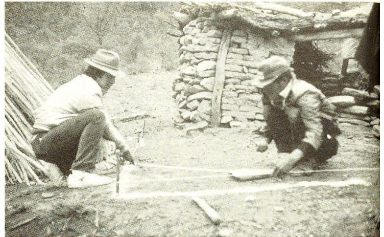
Sotto la guida di esperti, e con materiali locali, si inizia il risanamento delle abitazioni.
