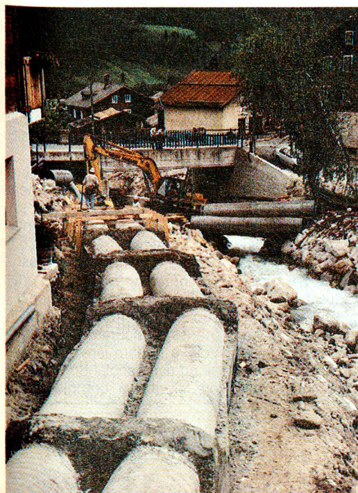
Il torrente della Münstiger viene provvisoriamente incanalato in condotte.
