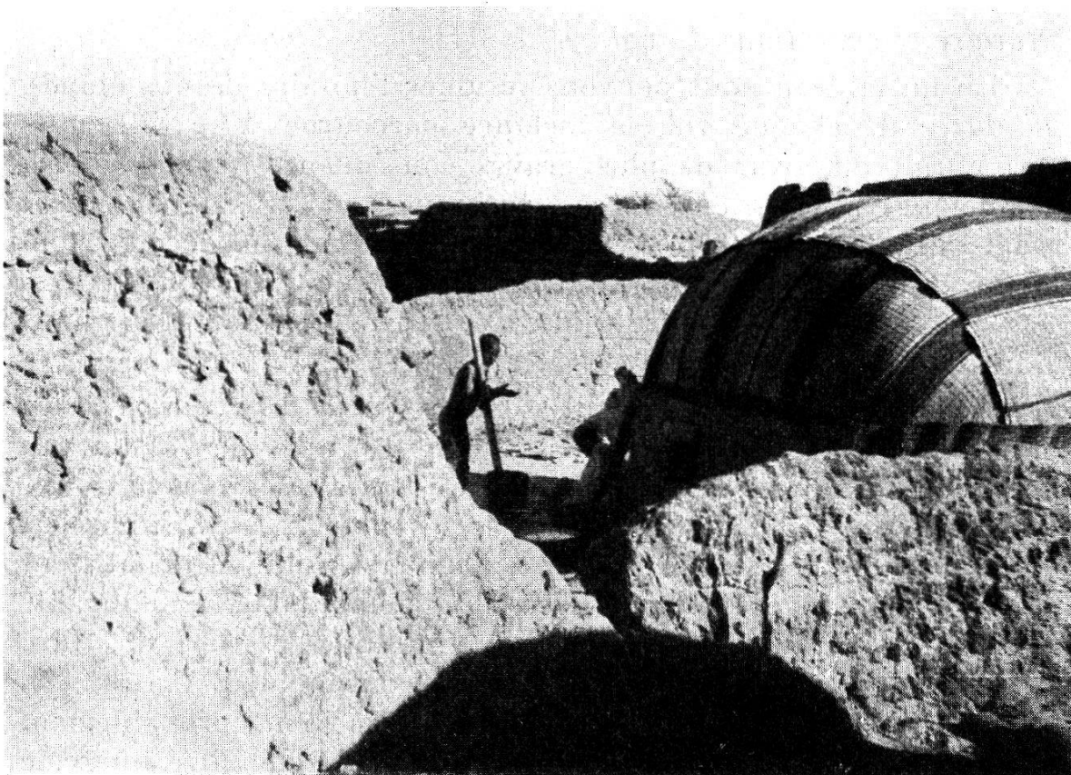
Photogr. 4. « Case-tortue » des Sonraïs de Goundam. Il s'agit d'une demeure de nattes issue des tentes nomades, en particulier des tentes des Bellah (captifs des Touaregs soudanais) et très proche par sa forme et son matériau des tentes des Kel-Aïr.
