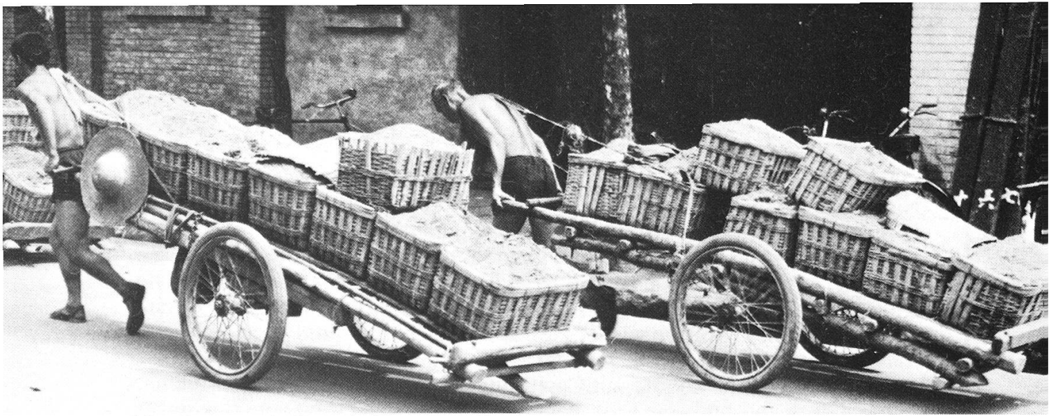
Mörteltransport in Chengdu (Foto: F. Häfliger)
