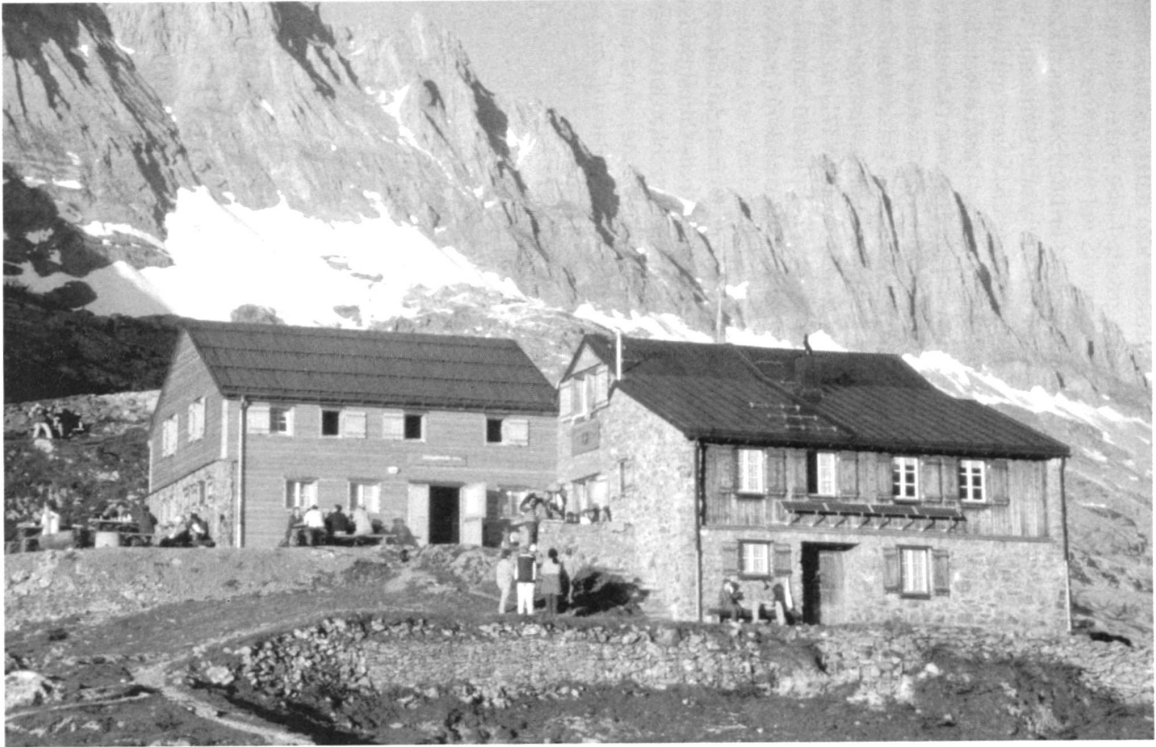
Die Windgällenhütte mit dem neuen, zweistöckigen Anbau, der das Schlafplatzproblem löst.
