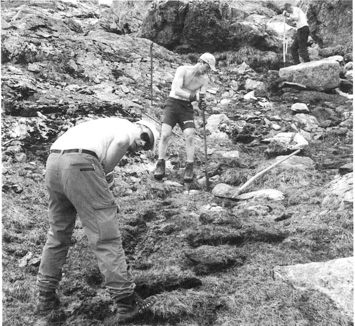
Aktive bei der harten Aushubarbeit für die neue Wasserleitung.
