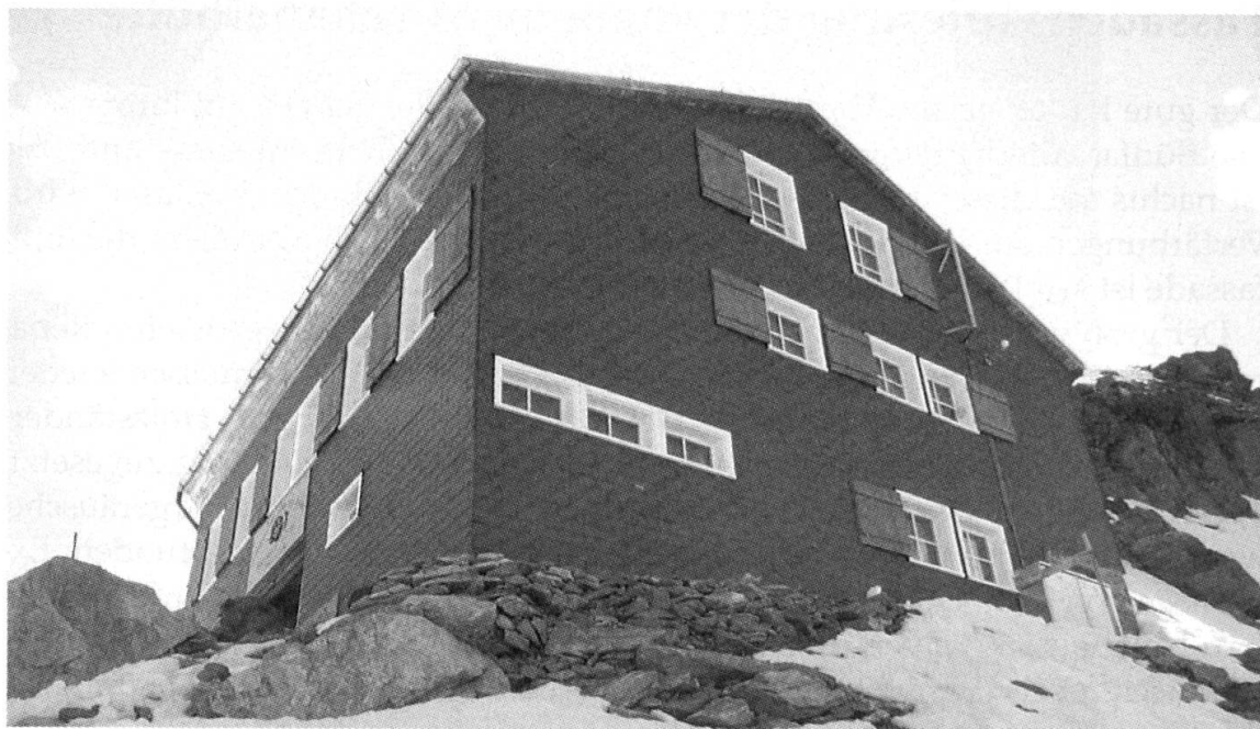
Die Nordfassade vor der Sanierung...
