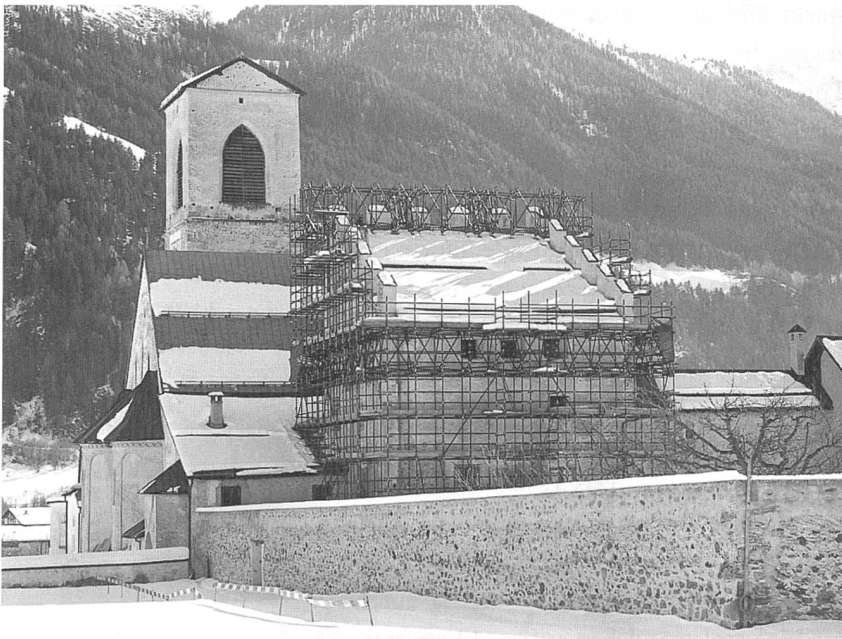
Abb. 3: Müstair 1997, Kloster St. Johann; Plantaturm mit Spezialgerüst und Sicherungsgurt im Winter 1997. Im Hintergrund die Klosterkirche.
