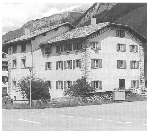
Abb. 3: Pignia Bad. Häusergruppe Nr. 65/66. Geschütztes Ensemble, eingedeckt mit Steinplatten.
