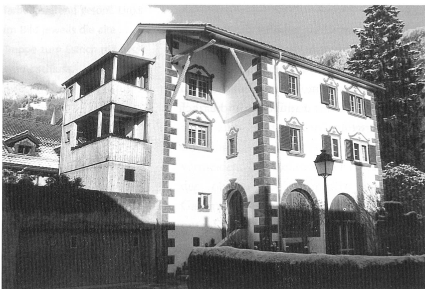
Abb. 29: Malans, Haus Grass von Südwesten. Links der neue Terrassenanbau.
