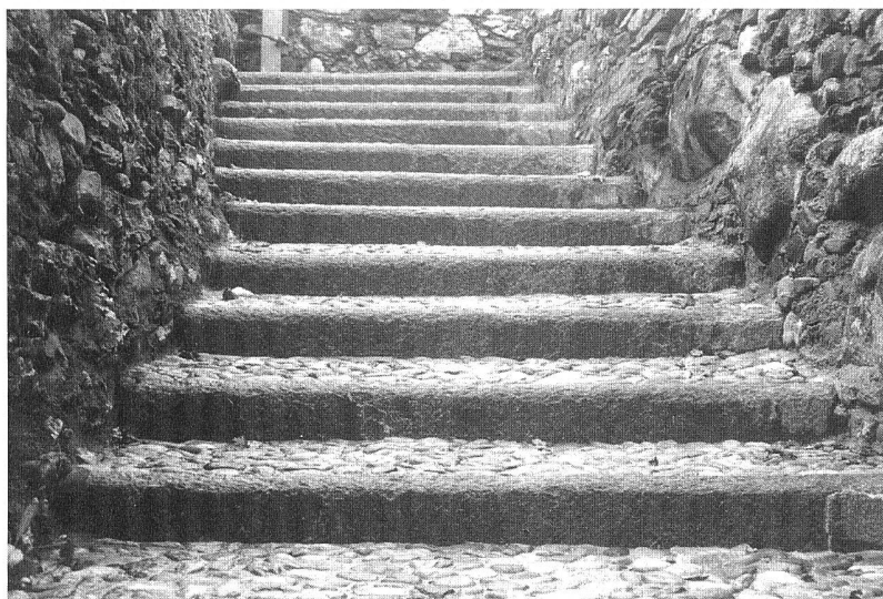
Abb. 98: Roveredo - Toveda, Treppenstufen mit Bollenpflasterung.
