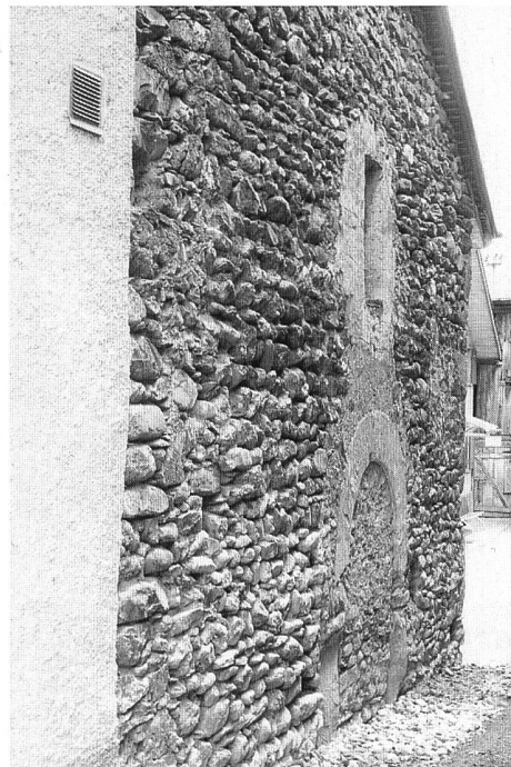
Abb. 101: Cazis, Kapelle St. Wendelin. Die unverputzte Westfassade. Ansicht von Nordwesten.
