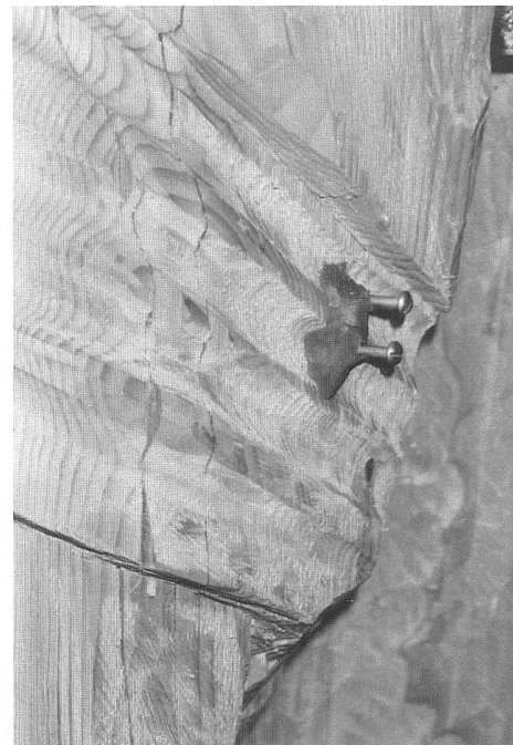
Abb. 132: Um die Feuchtigkeit im Innern des Holzes messen zu können, werden zwei Schrauben (je 12,5 cm lang) in die Rückseite der Figuren gedreht und an einen Stromkreis angeschlossen. Der so messbare elektrische Widerstand gibt Aufschluss über die gegenwärtige Holzfeuchtigkeit.
