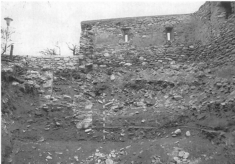
Abb. 72: Rodels, Parzelle 275. Gebäuderest mit Auffüllschichten bei Grabungsbeginn. Ansicht von Norden.
