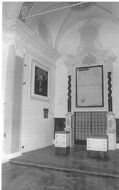
Abb. 102: Poschiavo, altes Frauenkloster. Die Klosterkirche während der Restaurierung. Blick gegen Osten in den Chor (Raum Nr. 4). Das Altarbild fehlt noch.
