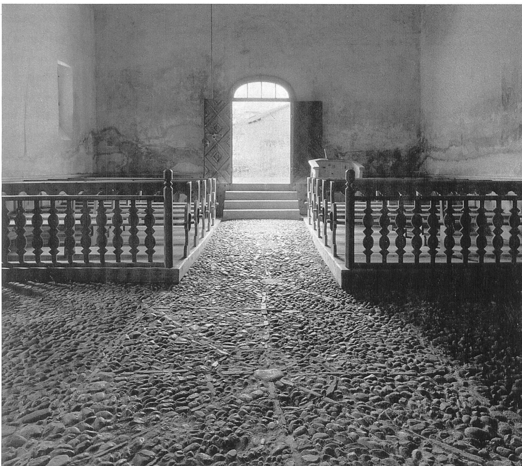
Abb. 120: Evangelische Ferialkirche Garsun. Bollensteinpflasterung mit sternförmigem Muster im Gehbereich des Schiffes. Ansicht von Osten.
