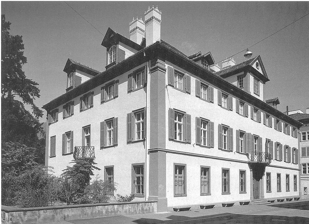
Abb. 130: Chur, Altes Gebäu. Fassade zur Poststrasse nach der Restaurierung 1999. Spätbiedermeierliche Fenstergitter im Erdgeschoss. Fensterteilung von 1953.
