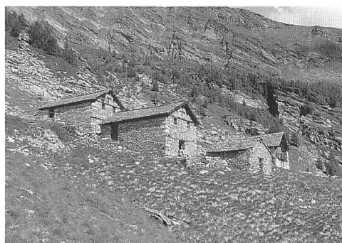
Abb. 164: Alp da Lughezzon. Die zwei vorderen Höfe mit bergseitigem Eingang zur cassina und talseitigem Stallzugang sowie der Käsekeller sind ganz in Trockenmauerwerk erstellt. Ansicht von Südosten.
