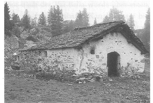
Abb. 152: Alp da Cavloc, Alte Sennerei. Ansicht von Südosten. Links oberhalb des Eingangstores ist das Rauchloch zu erkennen.
