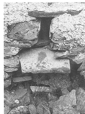
Abb. 154: Alp da Cavloc, Alte Sennerei. Ausguss an der Südfassade, von wo die Schotte direkt in einen aussen liegenden Schweinetrog geleitet wurde.
