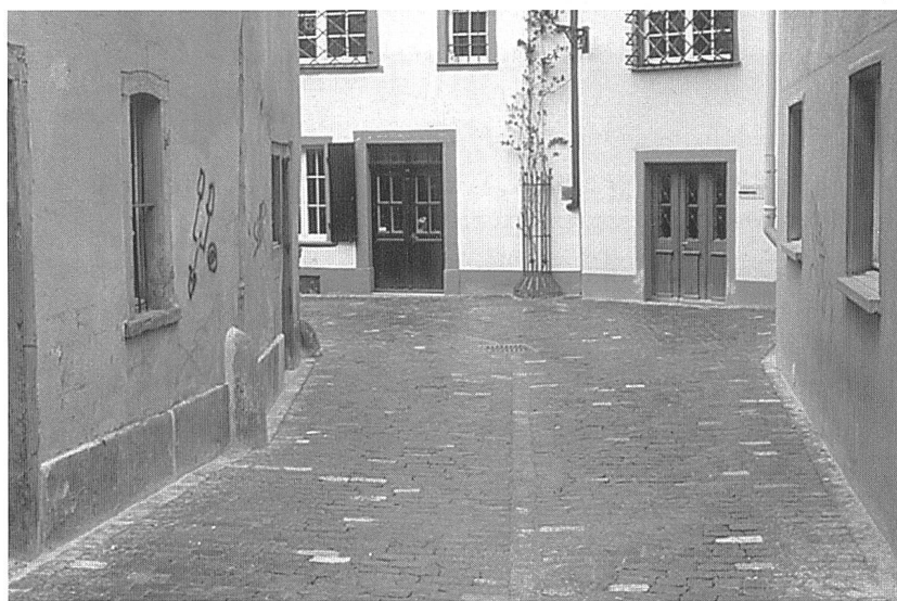
Abb. 171: Ausschnitt der 1998 wiederhergestellten, in den Sand gesetzten Pfläste- rung auf dem Majoranplatz und in der Paradiesgasse in Chur.
