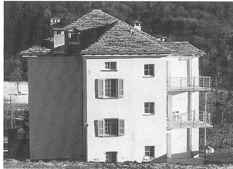
Abb. 104: Die "Casa a Mar- ca" in Leggia nach der Aus- senrestaurierung. Rechts vom Treppenhausrisalit die neuen Balkone.
