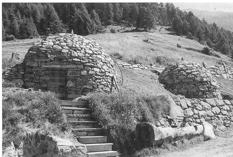
Abb. 103: Brusio-Viano. Instandgesetzte Milchkeller ("Cròt") bei Isola.
