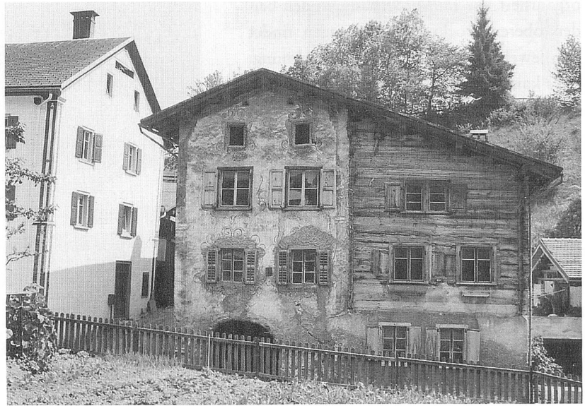
Abb. 149: Trin, Haus Nr. 34. Nordfassade, Vorzustand.
