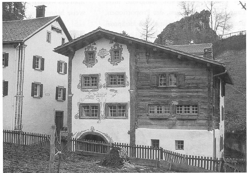
Abb. 150: Trin, Haus Nr. 34. Nordfassade, Nachzustand.
