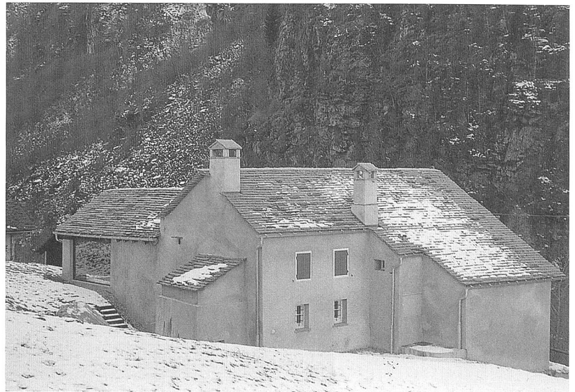
Abb. 156: Selma, Haus Nr. 2. Ansicht von Nordosten.
