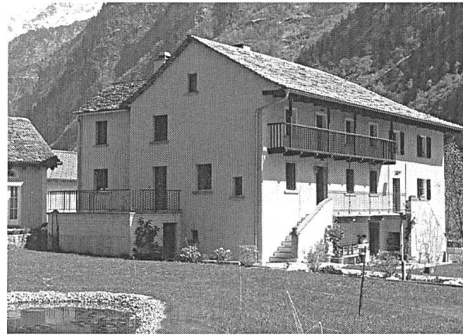
Abb. 105: Lostalio-Cabbiolo, Wohnhaus Nr. 97. Ansicht von Südwesten.
