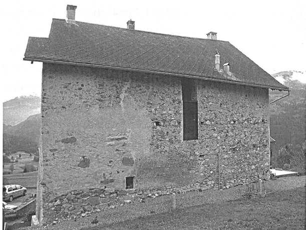
Abb. 135: Brienz/Brinzauls-Vazerol, Tgesa Gronda. Der neue Zugang von Norden in die Wohnung des zweiten Geschosses. Als Material wurde Eisen gewählt, um den Eingriff in die historische Substanz lesbar zu machen. Die den Eingang erschliessende Aussentreppe fehlt noch.
