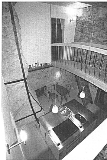
Abb. 143: Brienz/Brinzauls-Vazerol, Tgesa Gronda. Die Küche im zweiten Stock. Auch hier wurden die alten Bestandteile erhalten. Der bestehende Kamin musste mit einem "Eisenkorsett" gesichert werden. Die Galerie verbindet die beiden Kinderzimmer durch die zweistöckige Küche.
