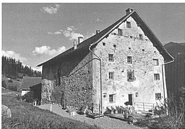
Abb. 136: Brienz/Brinzauls-Vazerol, Tgesa Gronda. Ansicht von Nordwesten. Zu sehen sind die beiden neuen Türen. Jene an der Nordfassade noch ohne Aussentreppe.
