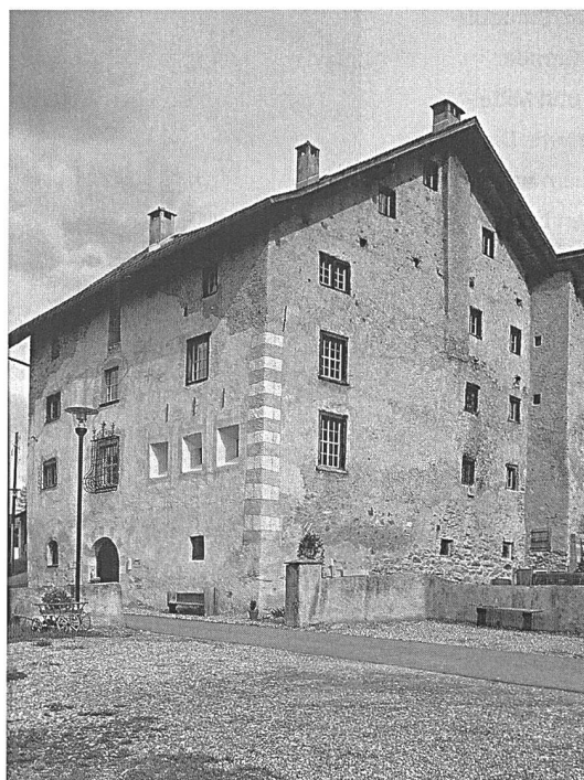
Abb. 137: Brienz/Brinzauls-Vazerol, Tgesa Gronda. Südostansicht. In der rechten Hälfte der Südfassade, rechts über dem Haupteingang die drei wiederhergestellten gotischen Fensterchen. Diese waren im 19. Jahrhundert vergrössert worden.
