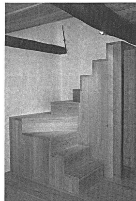
Abb. 150: Soazza, Haus Anderson Nr. 130/131. Ein- gangsgeschoss. Die neue interne Verbindung zwischen Arbeitsraum und Schlaf- zimmer.
