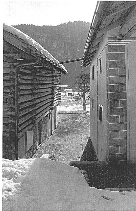
Abb. 173: Schnaus, Casa Oswald. Der massiv gemauerte Küchentrakt. Ansicht von Osten.
