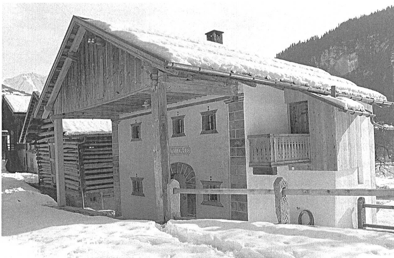
Abb. 172: Schnaus, Casa Oswald. Nordwestansicht des Hauses an der alten Oberländerstrasse. Die ursprüngliche Fassung der Fassaden ist bei der jüngst erfolgten Restaurierung wieder hergestellt worden.
