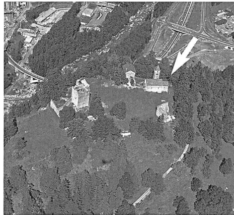
Abb. 35: Sils i. D., Burganlage Hohenrätien. Die Burganlage von Süden in einer Luftaufnahme aus dem Jahre 1997. Der Pfeil markiert die Ausgrabungsstätte.
