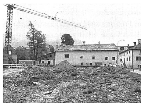
Abb. 148: Sils i.E./Segl, Baselgia/nördlich Haus Suosta Veglia. Übersicht der Baustelle am Beginn der Ausführung. Blick von Norden.
