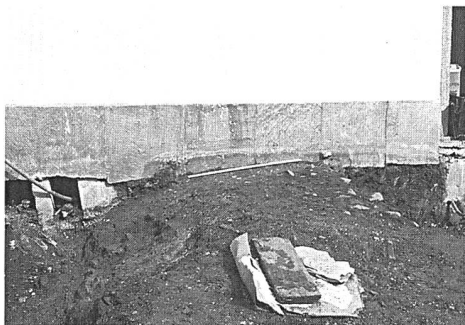
Abb. 131: Mesocco, Kirche San Pietro. Gewölbe südlich der Sakristei. Blick von Süden.
