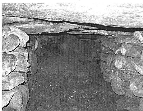
Abb. 145: Sils i.D., Sanierung Hauptstrassen. Blick von Süden ins Innere des Abwasserkanals.
