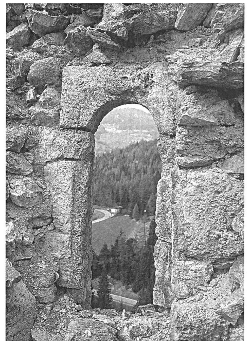
Abb. 211: Brienz/Brinzauls, Burgruine Belfort. Südtrakt, West-Innenwand, Rundbogenfenster in Tuffstein zu Saal im vierten Geschoss. Ansicht von Osten.
