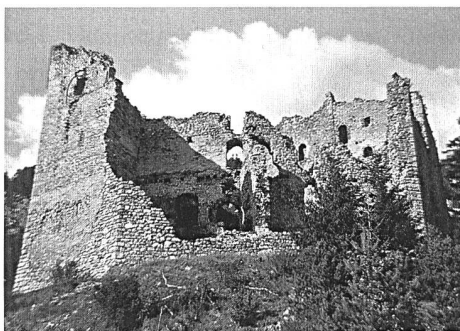
Abb. 193: Brienz/Brinzauls, Burgruine Belfort. Die Süd- wand der Burganlage wurde 1499 zum Einsturz gebracht. Ansicht von Süden.
