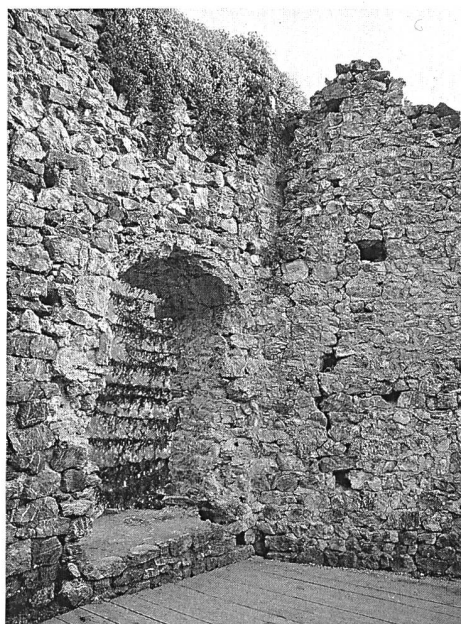
Abb. 205: Brienz/Brinzauls, Burgruine Belfort. Eingang in der Ostwand des Innenhofes (Planänderung). Ansicht von Nordwesten.
