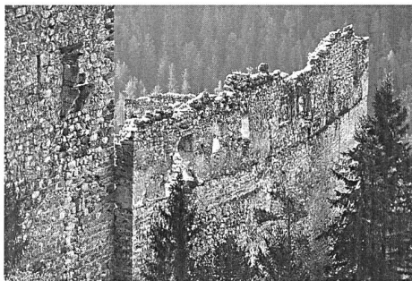
Abb. 192: Brienz/Brinzauls, Burgruine Belfort. Westfassade mit aufgelöster Mauerkrone. Blick von Nordwesten.
