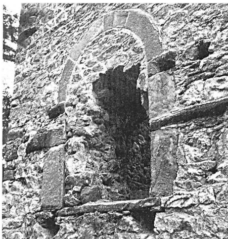
Abb. 204: Brienz/Brinzauls, Burgruine Belfort. Der zugemauerte Eingang in der Nordwand des Torturmes. Ansicht von Norden.
