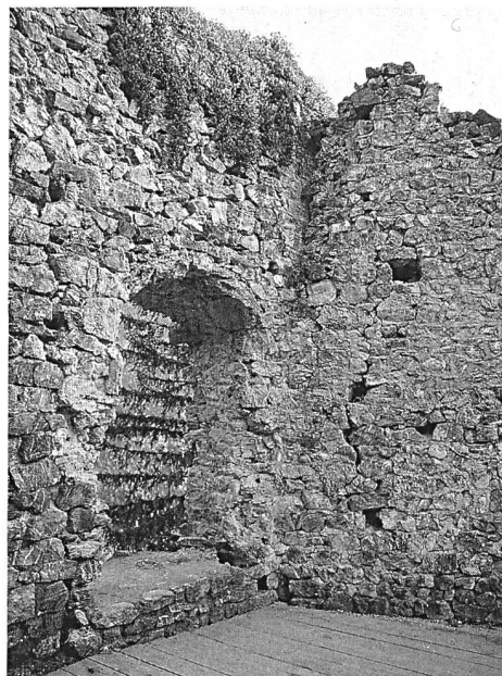
Abb. 205: Brienz/Brinzauls, Burgruine Belfort. Eingang in der Ostwand des Innenhofes (Planänderung). Ansicht von Nordwesten.
