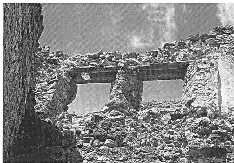
Abb. 212: Brienz/Brinzauls, Burgruine Belfort. West-Innenwand, Doppelfenster zur jüngsten Umbauphase 5. Ansicht von Osten.
