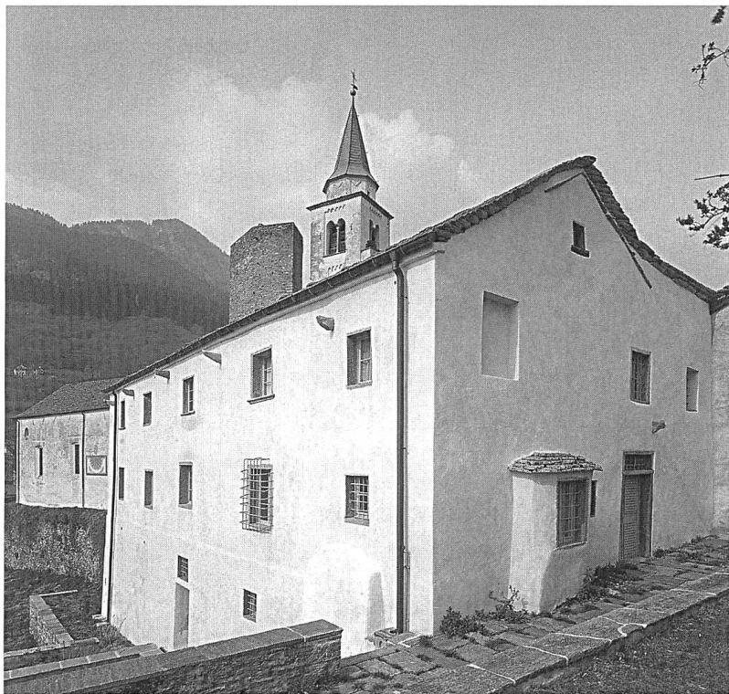
Abb. 217: Sta. Maria i. C., Pfarrhaus. Im Vordergrund das Pfarrhaus, dahinter Kirche und Burgturm. Ansicht von Südosten.
